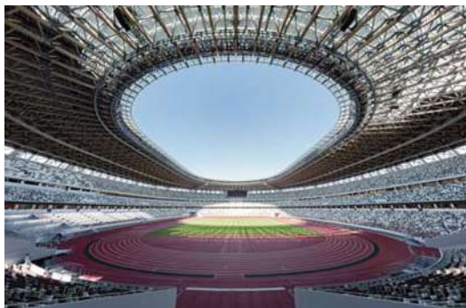
提供:大成建設株式会社 江間忠木材(株)は、国立競技場のスタンド観客席を覆う大屋根に使用する木材の製作・取付工事を担当しました
