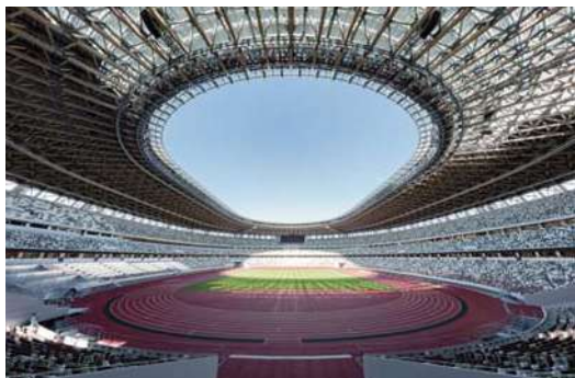
提供:大成建設株式会社 江間忠木材(株)は、国立競技場のスタンド観客席を覆う大屋根に使用する木材の製作・取付工事を担当しました
